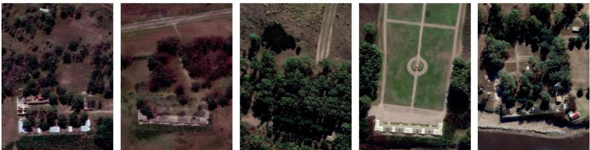
Figura 5. Arriba: Imagen satelital de la costa con la ubicación de las baterías. Debajo: detalle de cada Batería en su estado actual.
