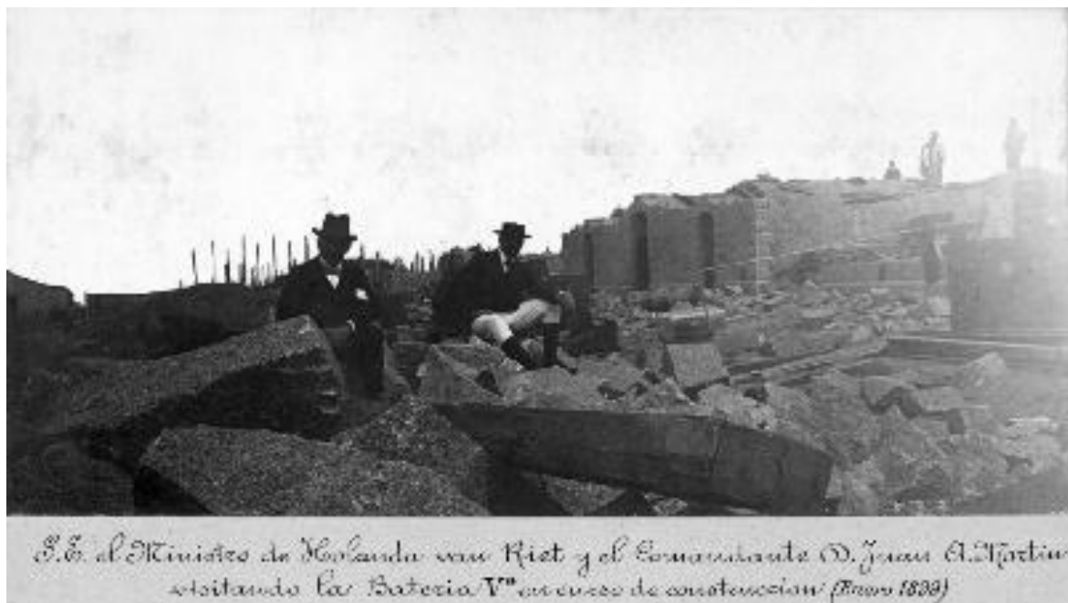
Figura 8. Fotografía en blanco y negro de la construcción de la Batería V. Se puede observar el sistema de construcción por bloques de piedra tallados y encastrados así como la incipiente forestación del complejo (1899).
