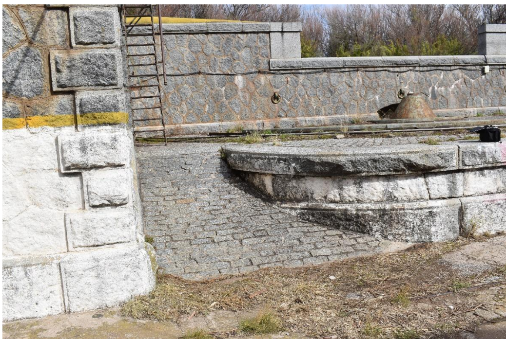
Figura 16. Fotografía del detalle de acceso a la plataforma del cañón por rampas, Batería III. Prospección 2 de septiembre 2021.
