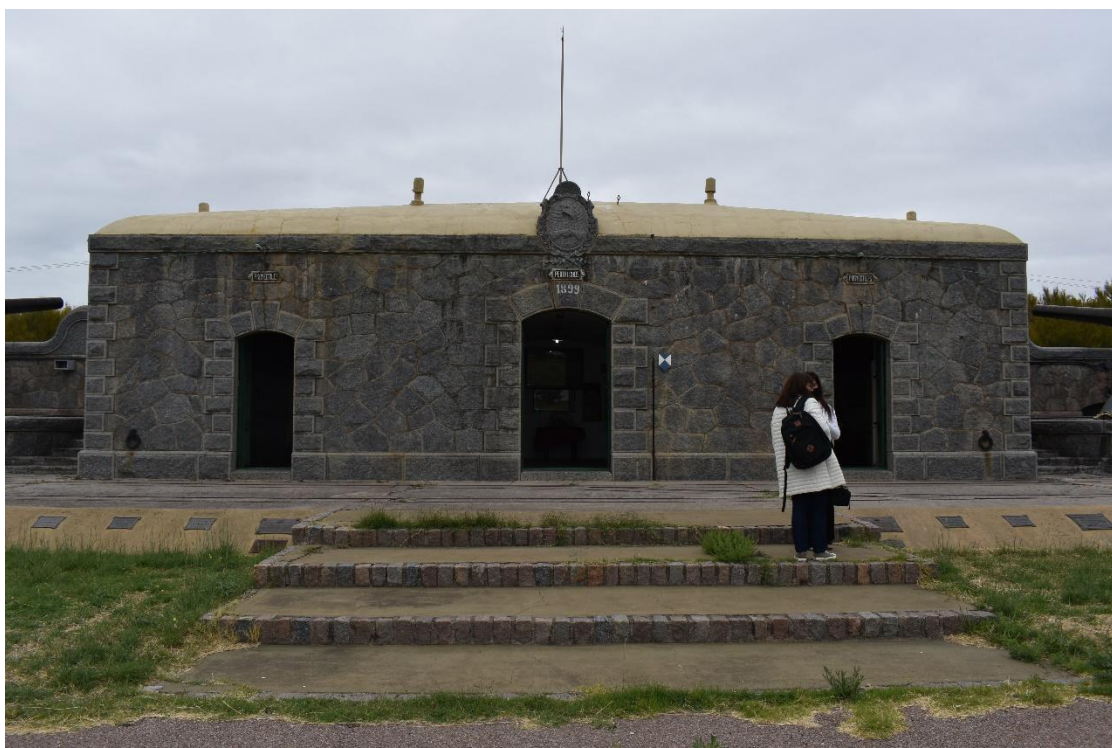
Figura 12. Fotografías de intervenciones para acceder a la Batería IV. Detalle escalones. Prospección 19 de marzo de 2021.
