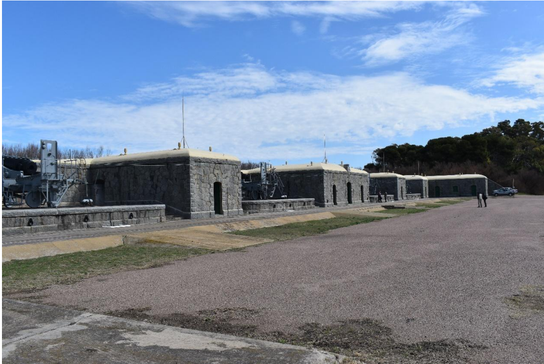
Figura 13. Fotografías de intervenciones para acceder a la Batería IV. Detalle rampas. Prospección 2 de septiembre de 2021.
