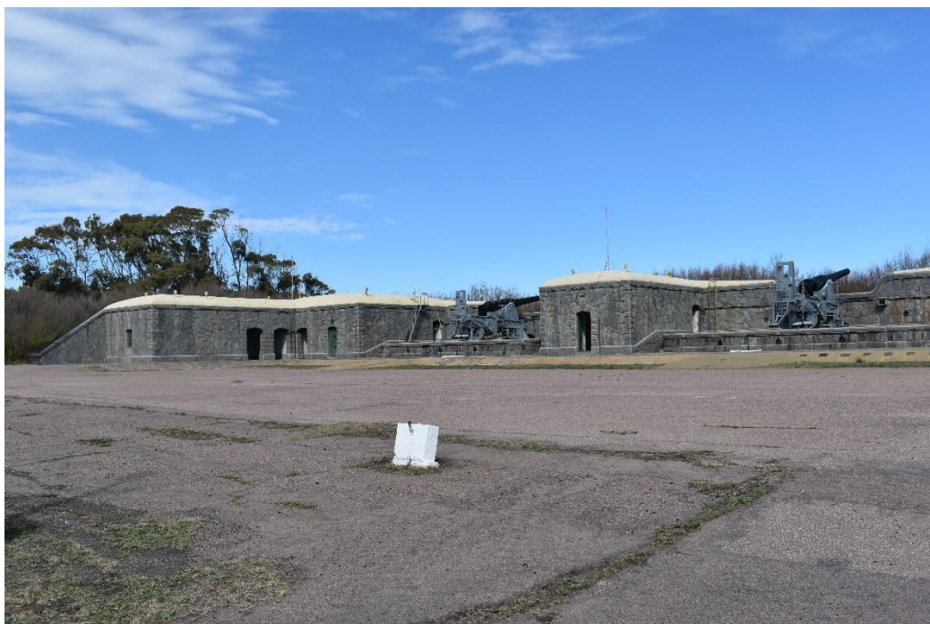
Figura 15. Fotografía del detalle de acceso a la plataforma del cañón por escalones, Batería IV. Prospección 2 de septiembre 2021.
